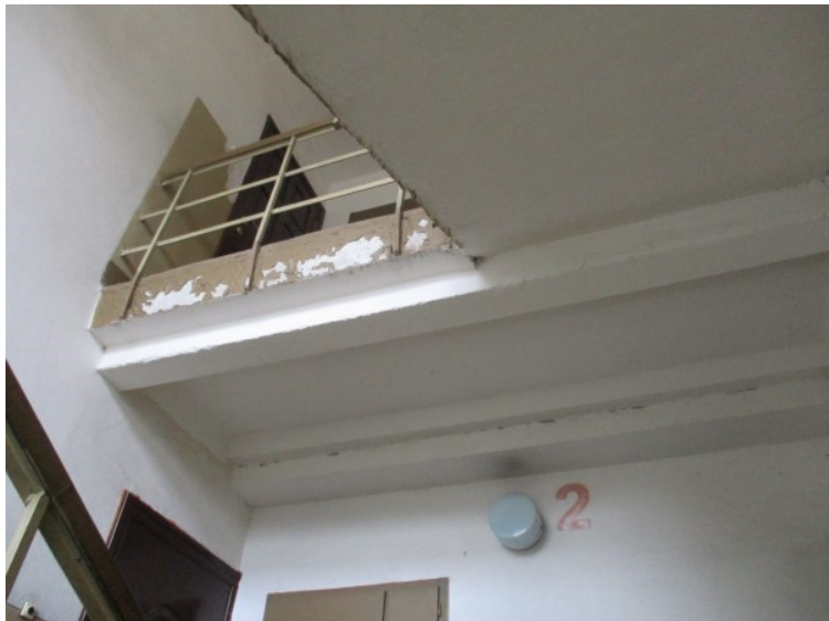
4.10.3. un 4.10.4. att. Starpstāvu dz-betona konstr. kāpnes
