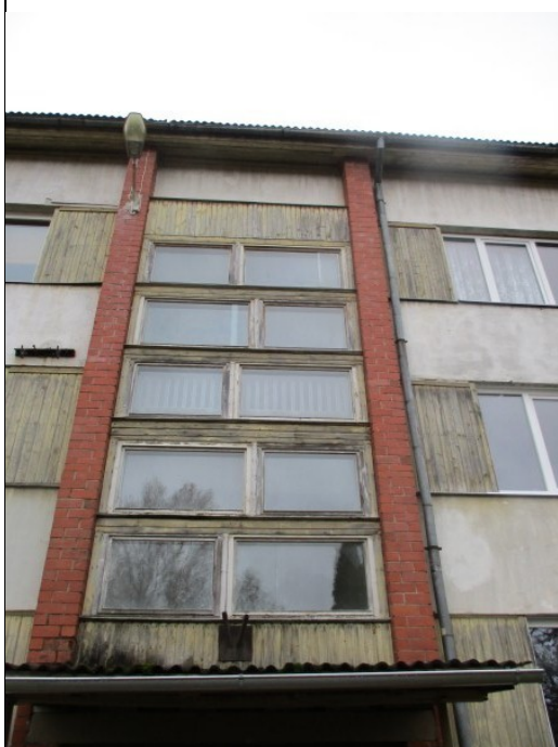
4.13.7. att. Koka konstr. logi kāpņu telpās
