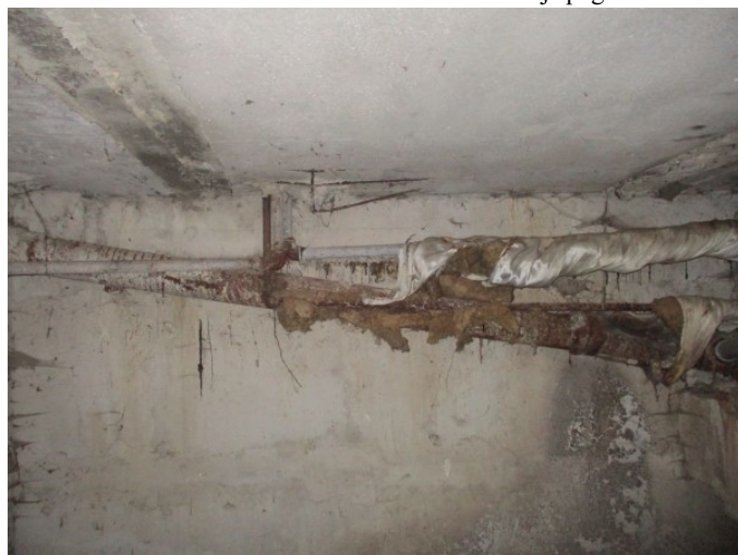
5.1.3. un 5.1.4. att. Kanalizācijas caurules- pārsvarā čuguna, kas ir novecojušas un bojātas
