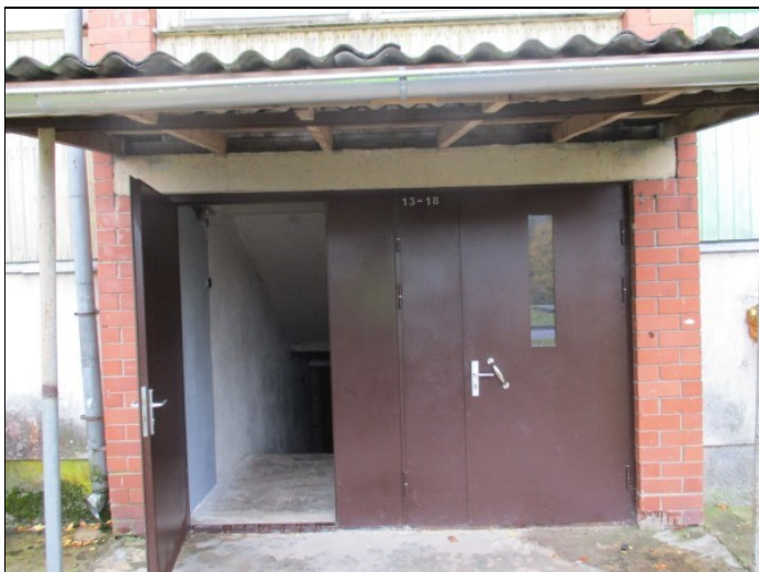
4.13.3. att. Metāla konstr. ieejas durvis kāpņu telpai „C”
