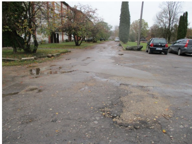
3.1.1. un 3.1.2. att. Asfaltbetona segums ar virsmas bojājumiem
