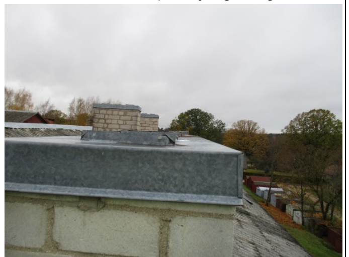
4.8.8. att. Atjaunoti virsjumta daļas mūra vēdināšanas izvadi
