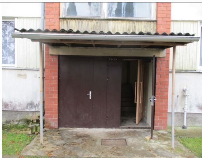
4.13.4. att. Metāla konstr. ieejas durvis kāpņu telpai „D”
