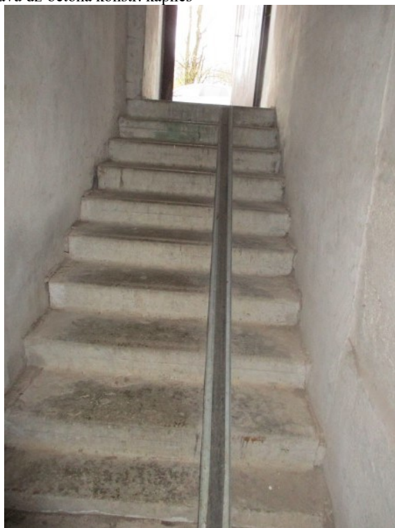
4.10.6. Dz-betona konstr. kāpnes noejai pagrabstāvā
