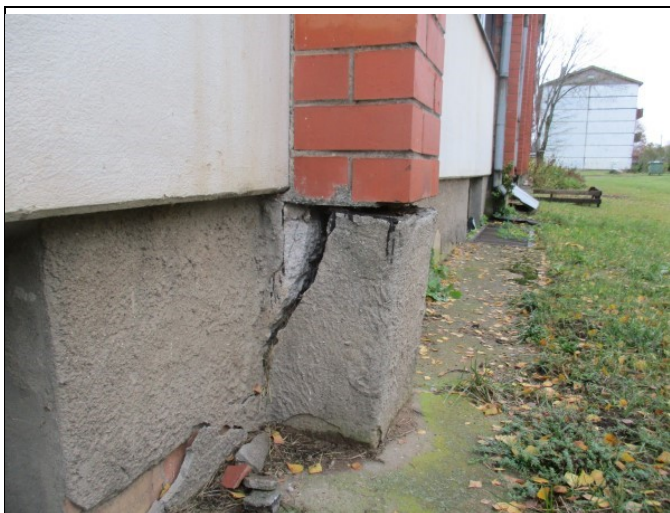
4.1.6.att. Pilastra pamatu atšķēlums
