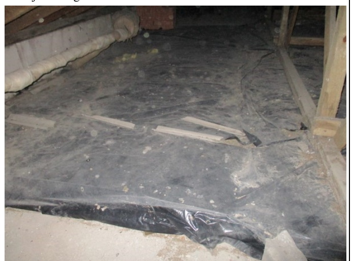
4.8.6. att. Siltināts bēniņu stāva pārseguma fragments
