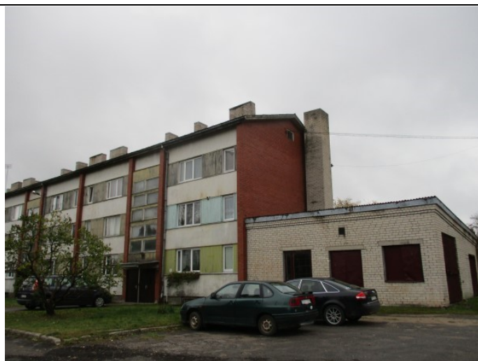
4.19.7. att. Ēkas ZR puses fasāde
