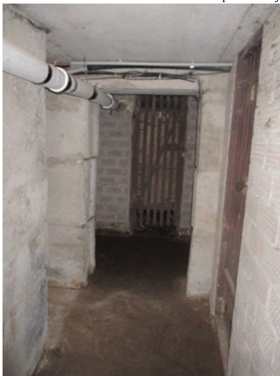
4.1.2. un 4.1.3. att. Dz-betona bloku pamati
