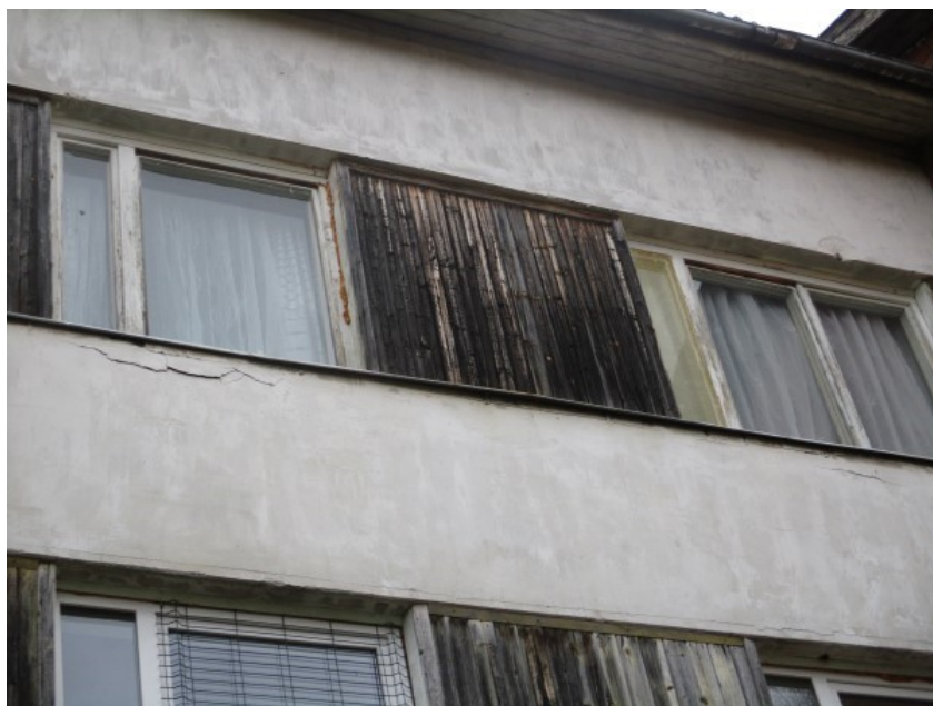
4.13.8. att. Koka un PVC konstr. logi dzīvokļos
