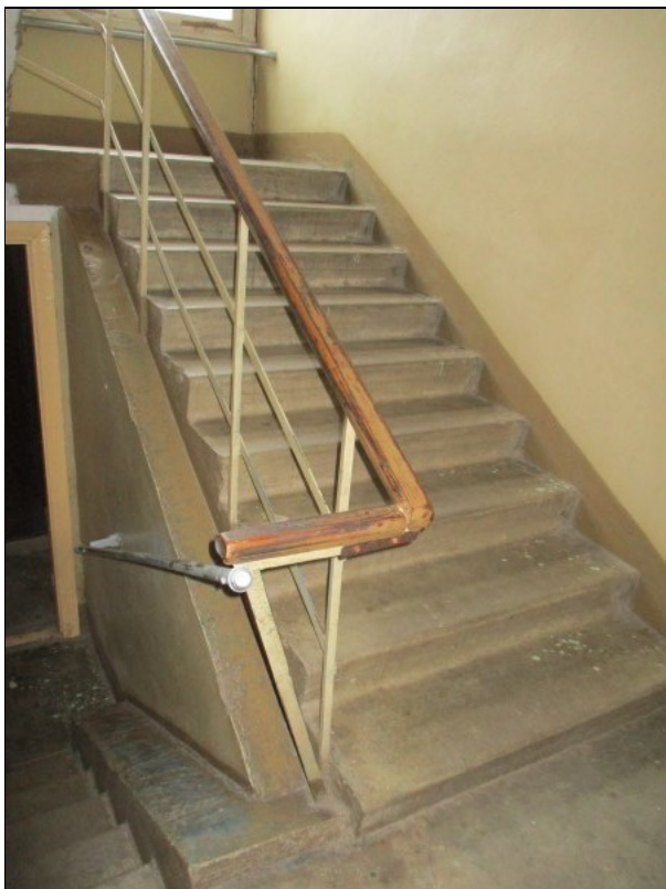
4.10.3. un 4.10.4. att. Starpstāvu dz-betona konstr. kāpnes
