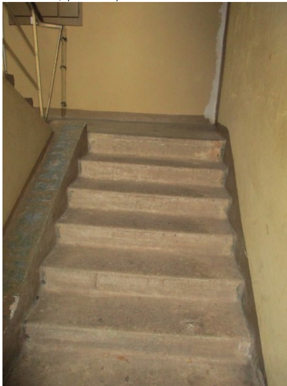
4.10.1. un 4.10.2.att. Starpstāvu dz-betona konstr. kāpnes
