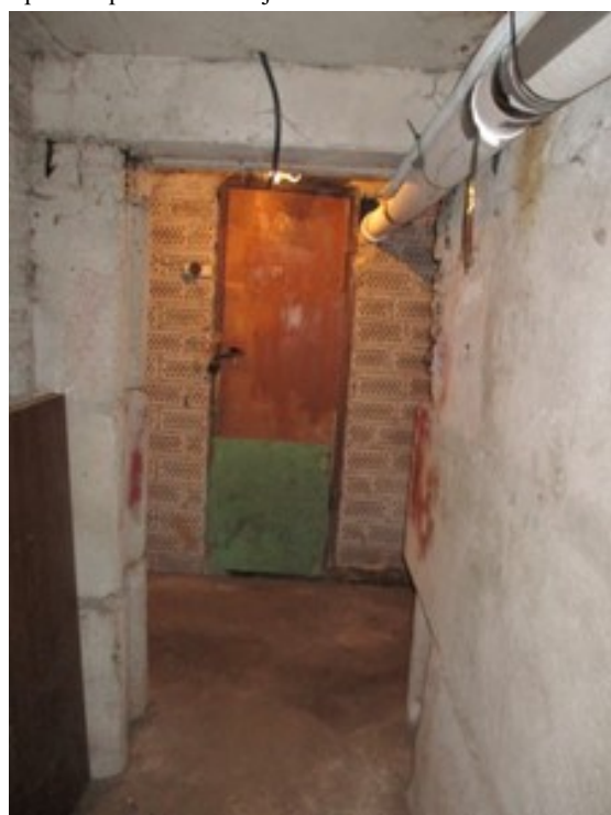
4.1.2. un 4.1.3. att. Dz-betona bloku pamati
