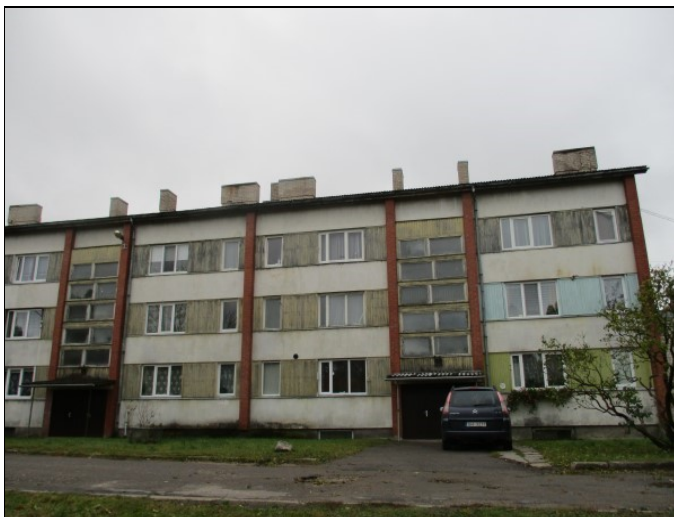
4.19.6. Ēkas ziemeļu puses fasāde
