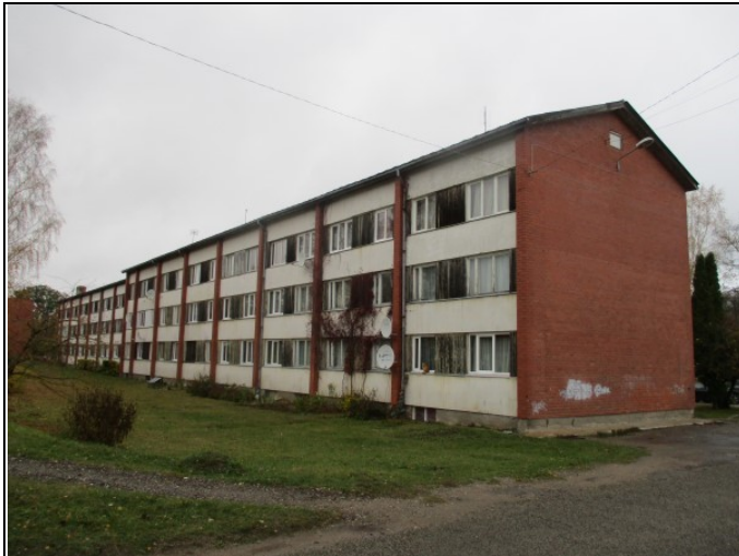
4.19.12. att. Ēkas DA puses fasāde
