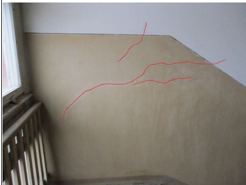
4.2.3. att. Plaisas mūra sienā (kāpņu telpā "D")
