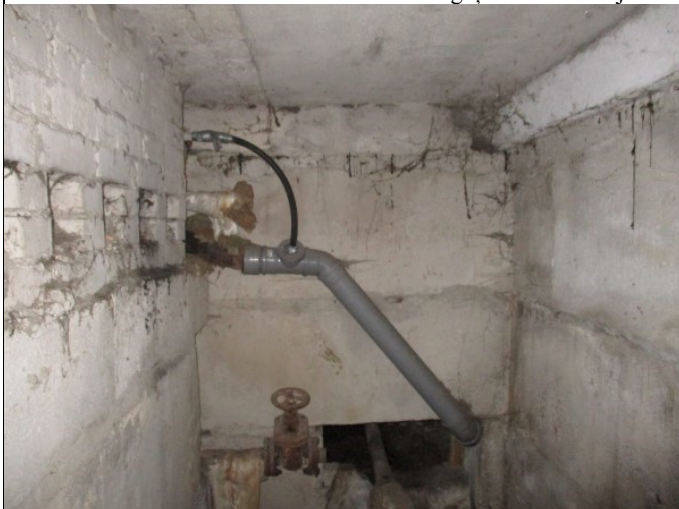
5.1.3. un 5.1.4. att. Kanalizācijas caurules- pārsvarā čuguna, kas ir novecojušas un bojātas
