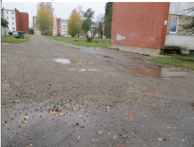
3.1.1. un 3.1.2. att. Asfaltbetona segums ar virsmas bojājumiem
