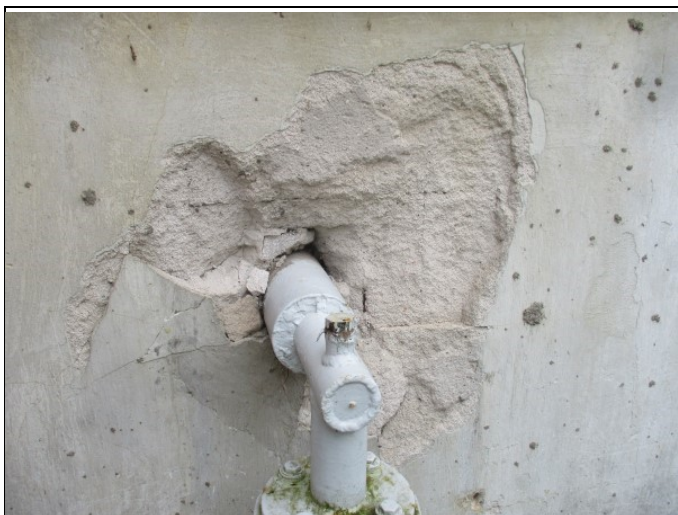
4.2.1. att. Paneļa virsmas erozija
