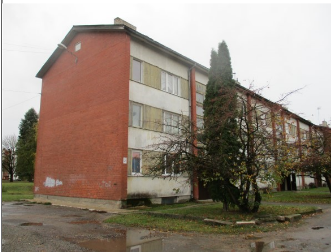
4.19.2. att. Ēkas ZA puses fasāde
