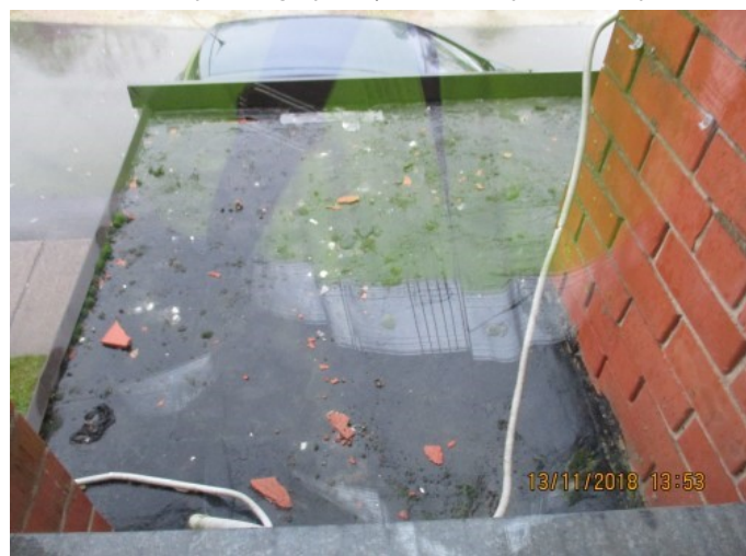
4.9.5. un 4.9.6. att. Ieejas mezglu jumtiņu seguma bojājumi
