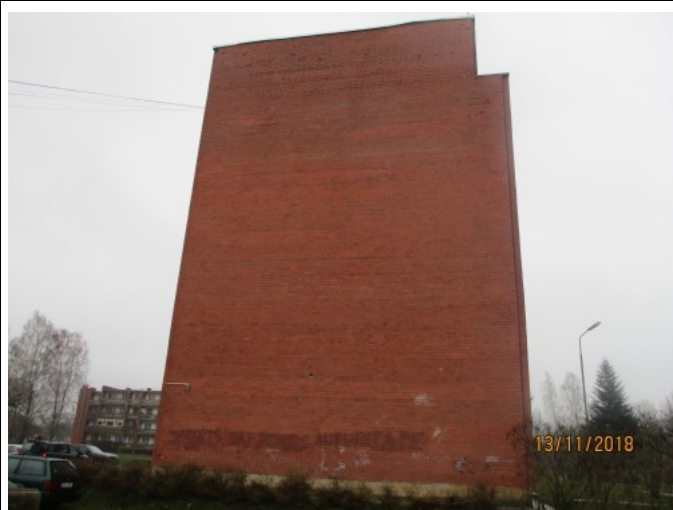
4.19.6. Ēkas rietumu puses fasāde
