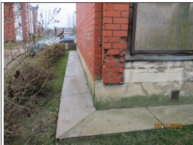
4.1.2. att. Pamatu betona apmale
