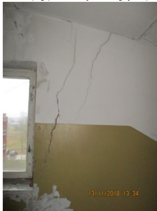
4.2.5. un 4.2.6. att. Plaisas kāpņu telpas Nr. 2 augšējo stāvu sienās
