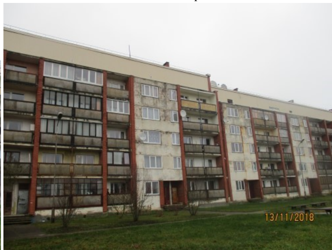
4.19.9. att. Ēkas dienvidu puses fasāde
