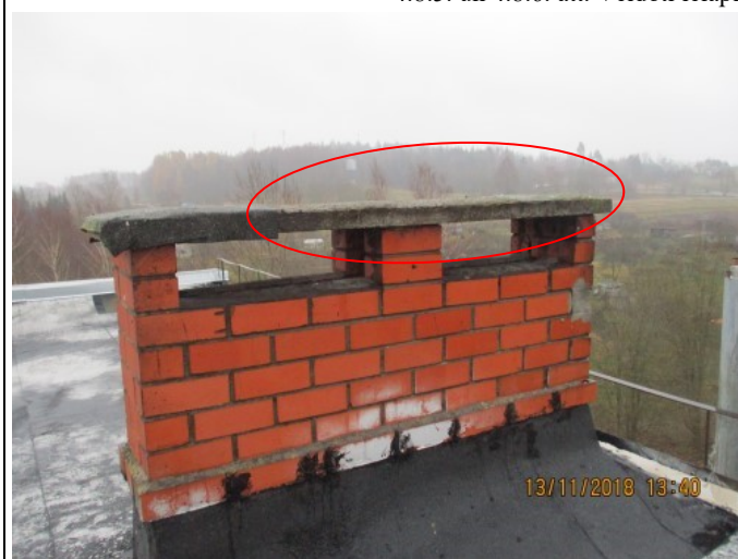
4.8.7. att. Daļēji nosegtā plātne ar bitumena ruļļmateriālu
