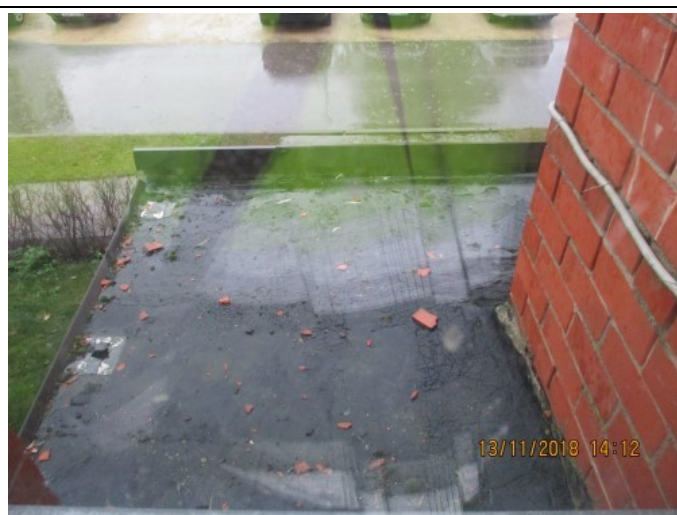
4.9.8. att. Ieejas mezgla jumtiņu seguma bojājumi
