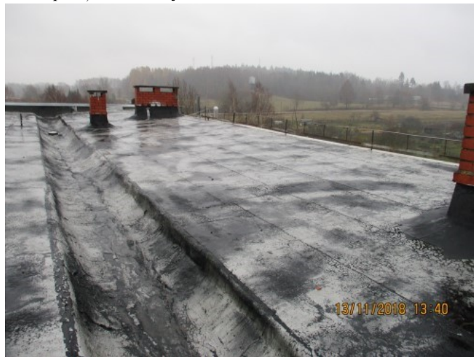
4.8.3. un 4.8.4. att. Bojāts/novecojis jumta segums
