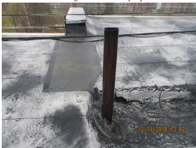
4.8.10. att. Izvadi jumtā bez atbilstoša pieslēguma un noseļceures
