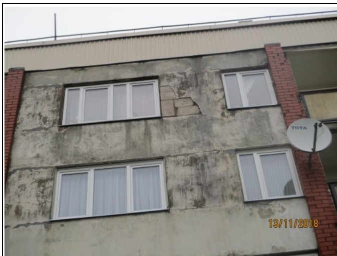
4.2.1. att. Starplogu daļas aizmūrētas ar gāzbetona blokiem
