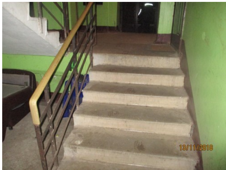
4.10.3. att. Kāpņu telpas kāpnes
