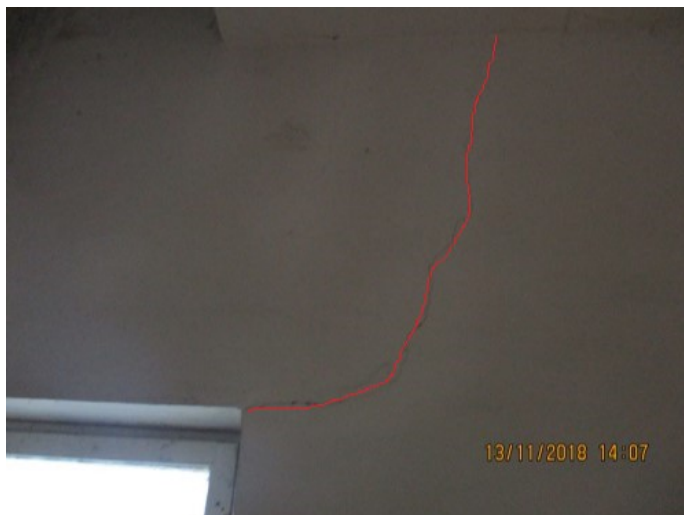
4.2.9. un 4.2.10. att. Plaisas kāpņu telpas Nr. 4 augšējo stāvu sienās
