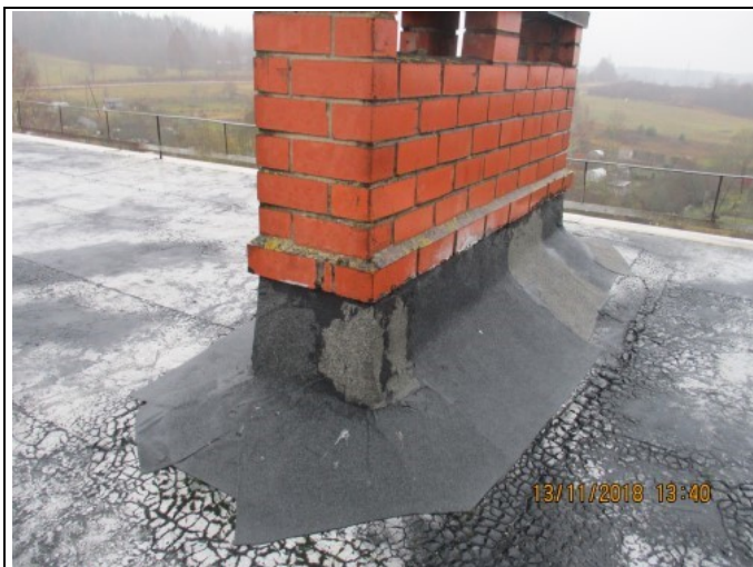
4.8.5. un 4.8.6. att. Veidoti ielāpi pieslēgumiem vēdināšanas šahtām
