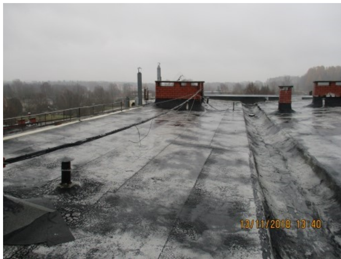
4.8.3. un 4.8.4. att. Bojāts/novecojis jumta segums
