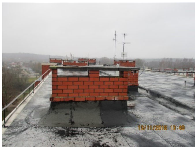
4.8.5. un 4.8.6. att. Veidoti ielāpi pieslēgumiem vēdināšanas šahtām
