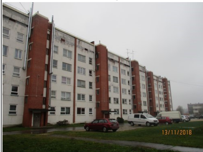
4.19.4. att. Ēkas ziemeļu puses fasāde
