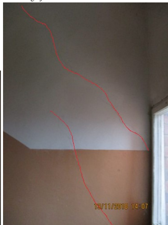
4.2.9. un 4.2.10. att. Plaisas kāpņu telpas Nr. 4 augšējo stāvu sienās
