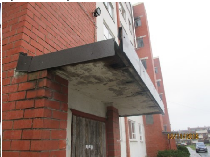
4.9.4. att. Ieejas mezgla jumtiņa konstrukcija ar notecējumiem
