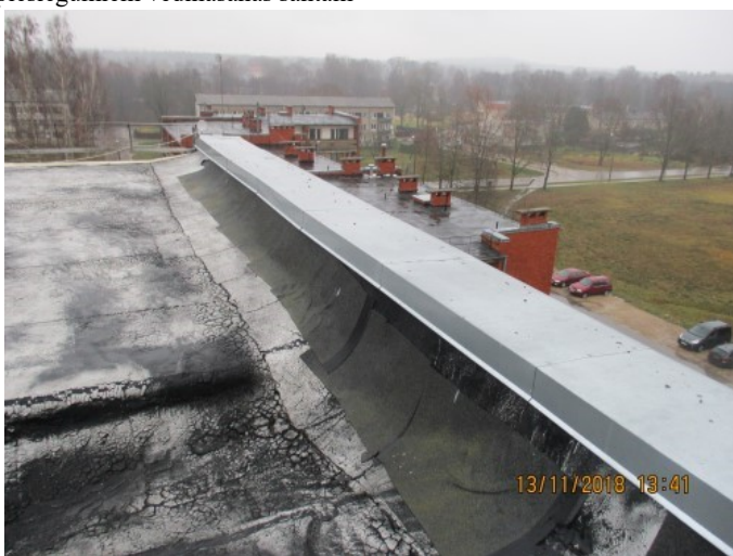
4.8.8. att. Remontēts segums un nomainīti parapetu skārda elementi
