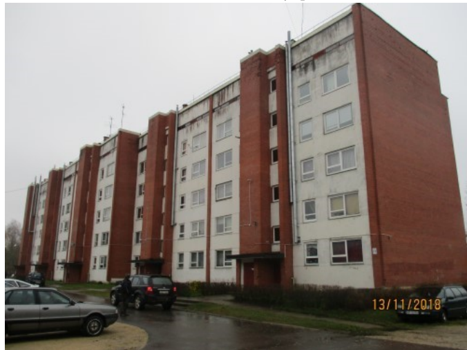
4.19.5. att. Ēkas ZR puses fasāde
