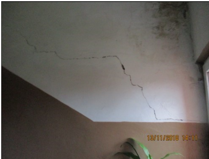
4.2.11. un 4.2.12. att. Plaisas kāpņu telpas Nr. 5 augšējo stāvu sienās
