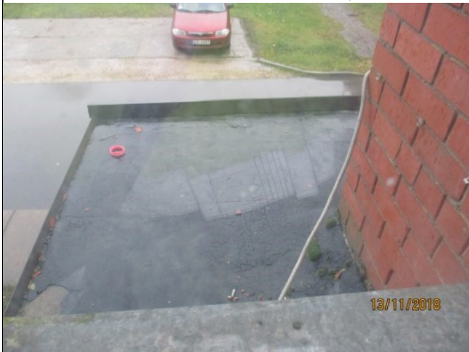
4.9.5. un 4.9.6. att. Ieejas mezglu jumtiņu seguma bojājumi
