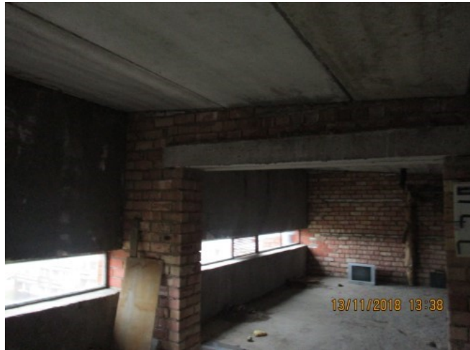
4.8.1. un 4.8.2. att. Jumta dz-betona paneļu konstrukcijas
