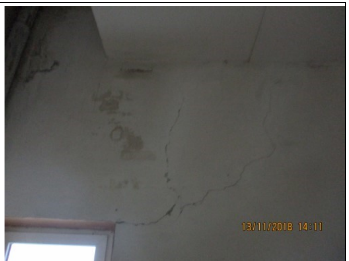
4.2.11. un 4.2.12. att. Plaisas kāpņu telpas Nr. 5 augšējo stāvu sienās
