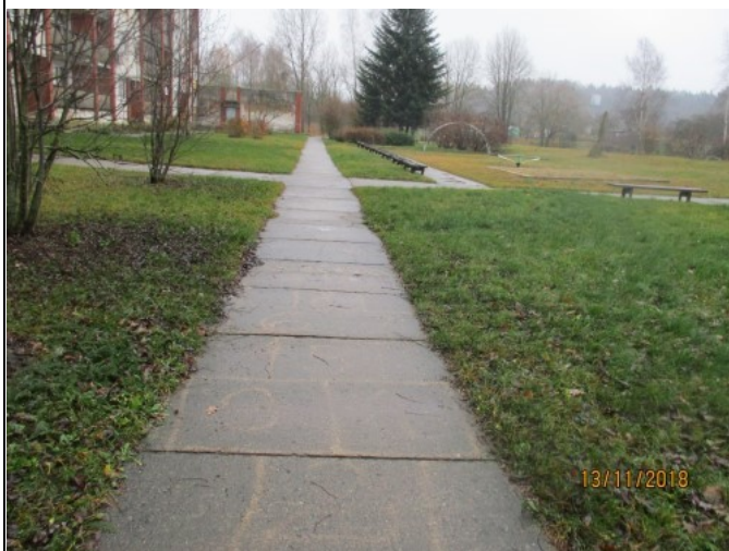
3.1.1. un 3.1.2. att. Dz-betona plāksņu segums ietvēm ēkas iekšpagalma daļā
