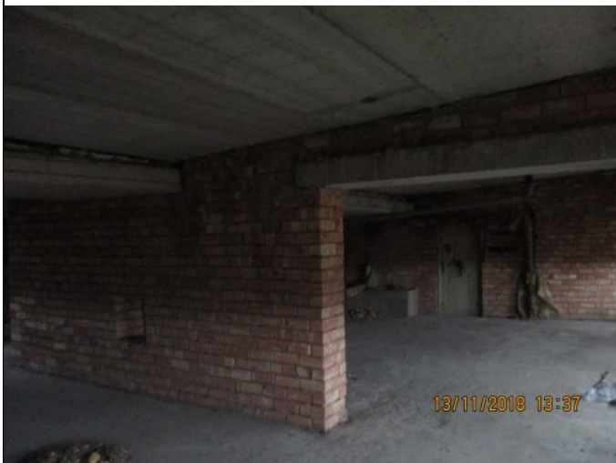
4.8.1. un 4.8.2. att. Jumta dz-betona paneļu konstrukcijas
