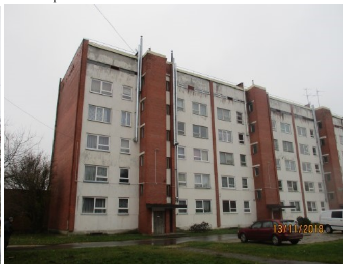
4.19.3. att. Ēkas ziemeļu puses fasāde
