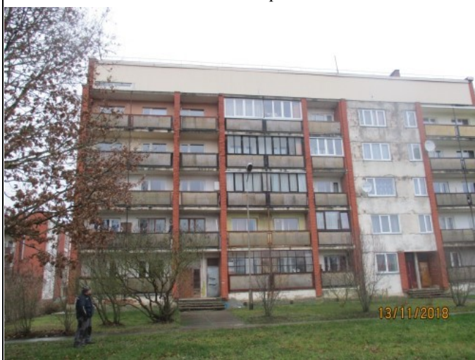
4.19.8. att. Ēkas dienvidu puses fasāde
