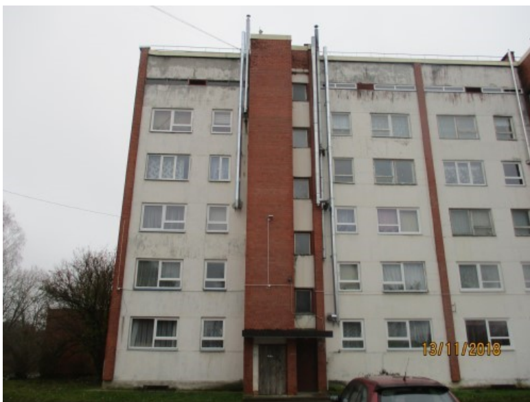
4.14.1. un 4.14.2. att. Izbūvēti dūmeņi uz ēlas ziemeļu puses fasādes
