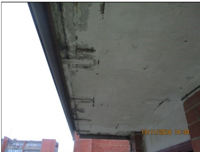
4.9.7. att. Ieejas mezgla jumtiņa konstrukcija ar notecējumiem
