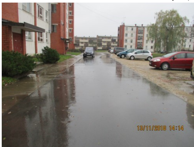
3.1.3. att. Asfaltbetona segums
