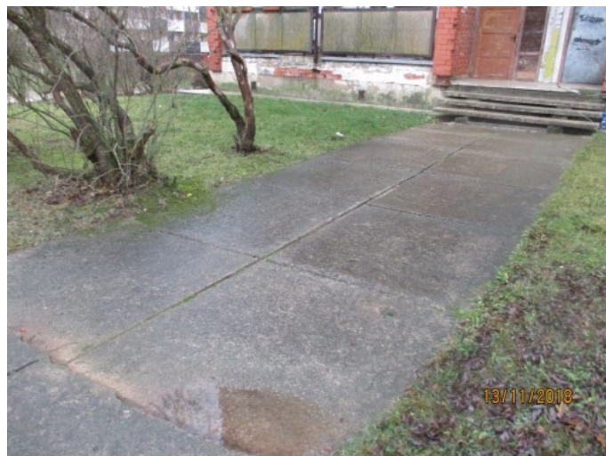
3.1.1. un 3.1.2. att. Dz-betona plāksņu segums ietvēm ēkas iekšpagalma daļā
