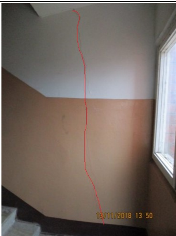
4.2.7. un 4.2.8. att. Plaisas kāpņu telpas Nr.3 augšējo stāvu sienās
